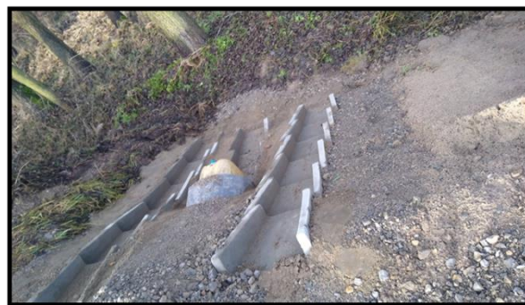
Droga gminna po wykonaniu remontu przepustu
