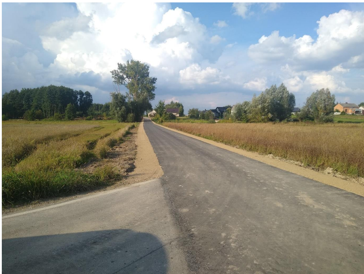
Droga gminna w miejscowości Mszadla Nowa
