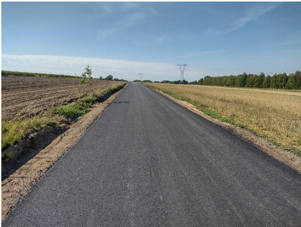
Droga po przebudowie
