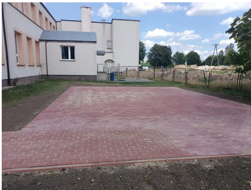
Prace wykonane przy budynku PSP w Łaguszowie
