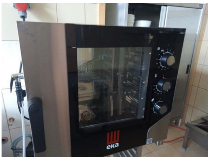
Wyposażenie kuchni po remoncie
