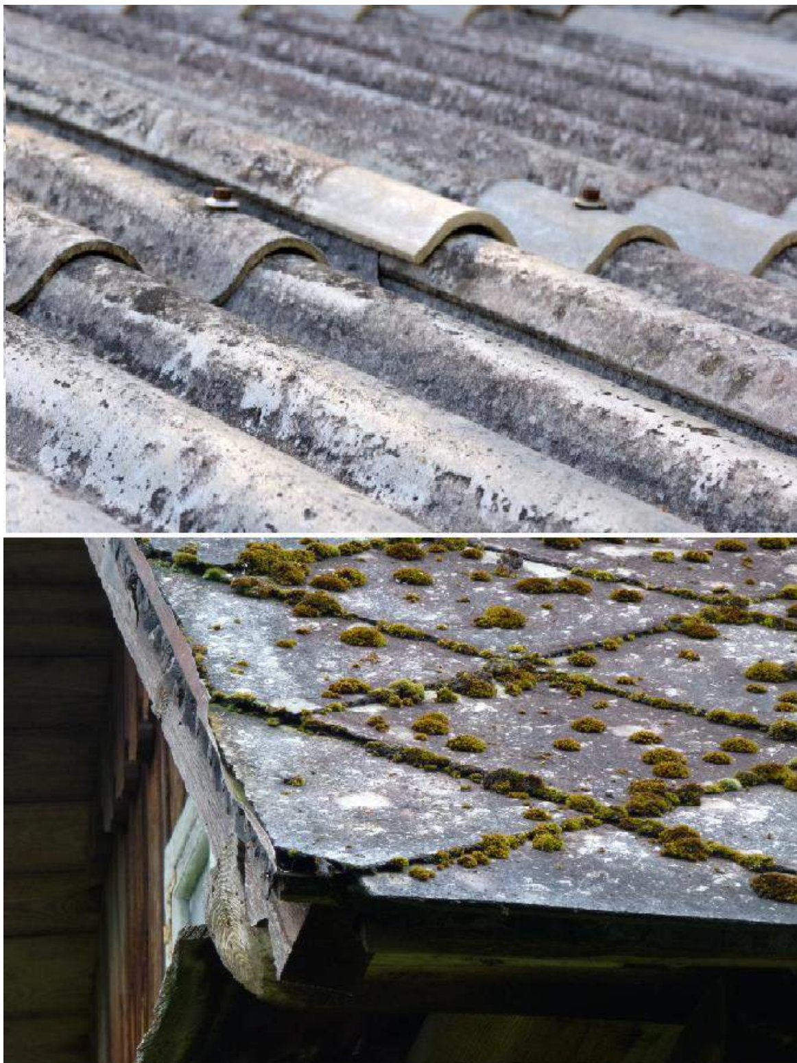
Rys. 1. Najpopularniejsze w Polsce wyroby azbestowo – cementowe: płyty faliste oraz romboidalne (Źródło: Fotografie własne)
